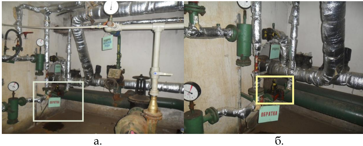
Рис. 7.4.2. Зовнішній вигляд (а) та вид на затворний клапан (б) системи автоматичного керування опаленням (КЗ «Лисичанська спеціалізована школа І-ІІІ ст. № 8»)
